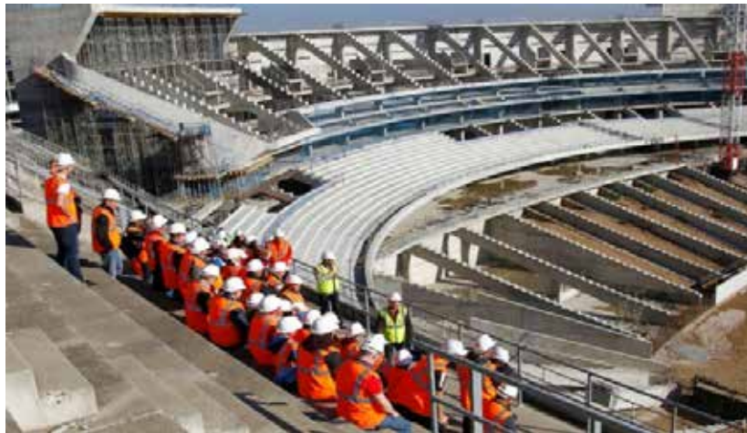
Figura 4: Proceso Constructivo del Estadio Club Atlético de Madrid ( https://img-estaticos.atleticodemadrid.com/system/fotos/972/showlarge/visita_peineta_pe%C3%B1as_10.jpg?1447253046 )
