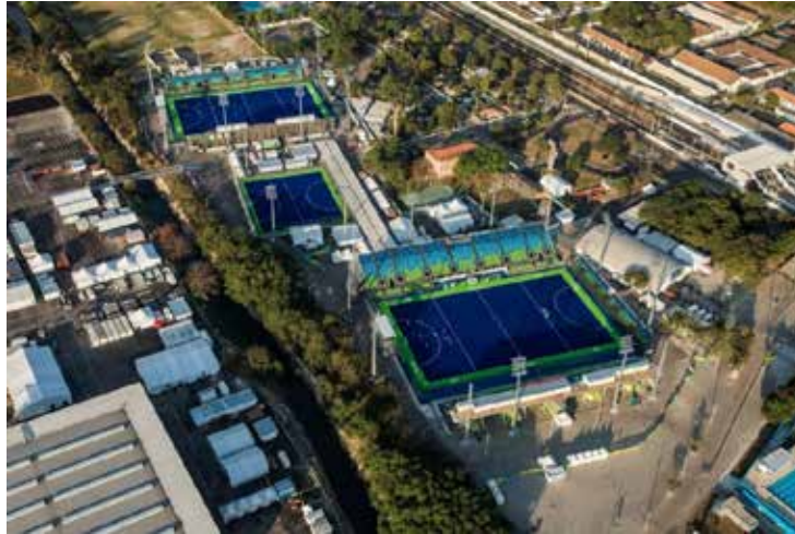
Figura 1: Algunas de las instalaciones del Parque Radical Olímpico
