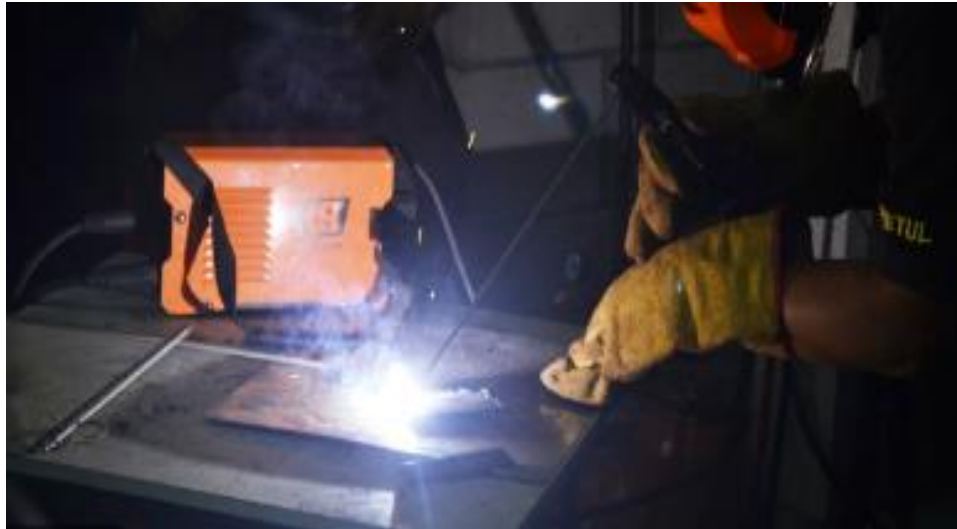
Figura 1: Soldadura con tecnología SMAW
