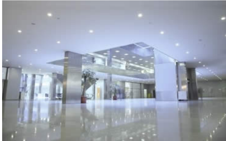
Figura 40: Piso epoxico. Fuente: http://www.pisosepoxicosindustriales.mx/images/muestra-de-obras/piso-epoxico-plaza-comercial.jpg (2012)
