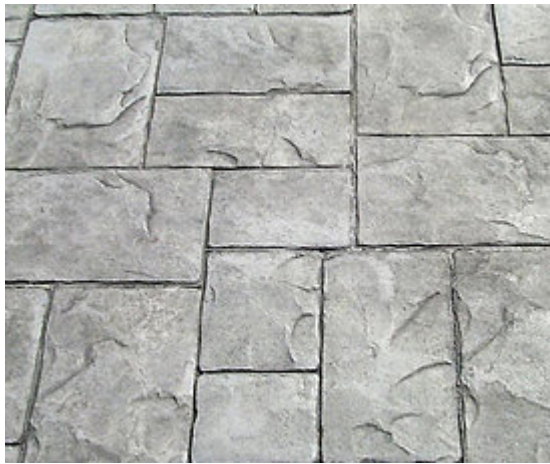
Figura 39: Concreto estampado. Fuente: https://www.stancolor.com.mx/texturas-concreto-estampado (2014)
