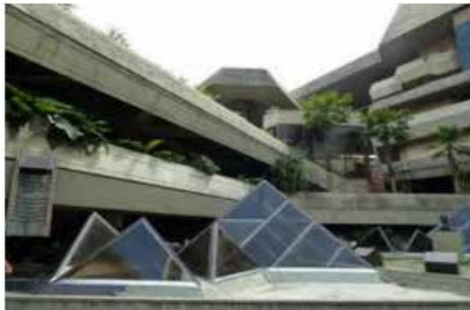
Figura 7. Vista interna Complejo Cultural Teatro Teresa Carreño
