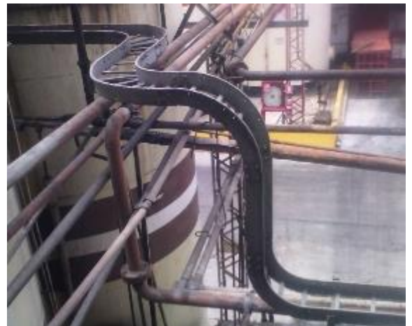
Gráfico N°20. Canales para cableado INDUSTRIAS DIANA C.A Fuente: Alejandro jaspe (2018)
