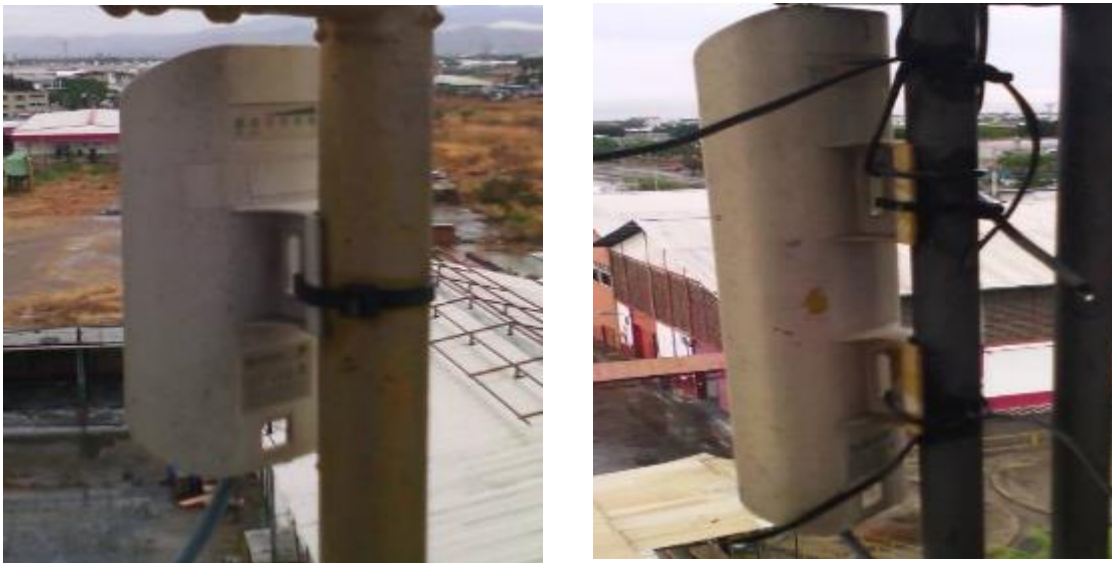
Grafico N°9. Radios ubiquiti torre repetidora Industrias diana C.A Fuente: Alejandro jaspe (2018)
