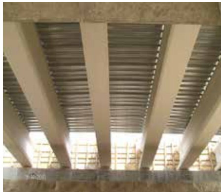
Figura 43. Losa acero a la vista (2018)
