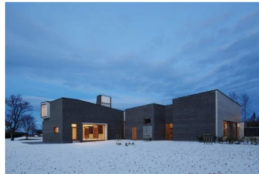
Figura 22. Fachada Posterior. Vista del Crematorio (2018, agosto 10), p. s/n
