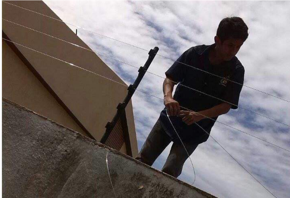
Figura Nro. 10 Colocacion de líneas
