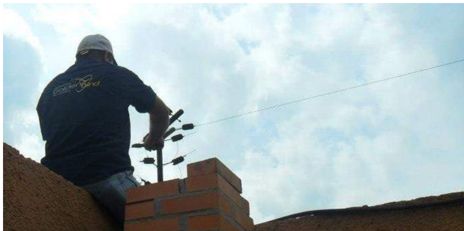
Figura Nro. 11 Colocación de líneas
