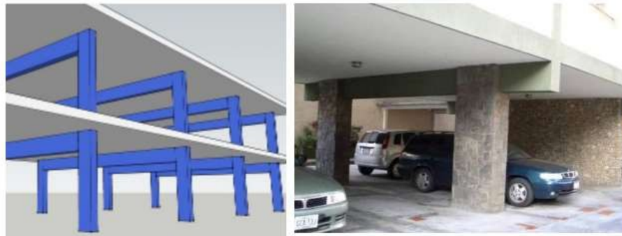
Figura 8 Ausencia de vigas altas
