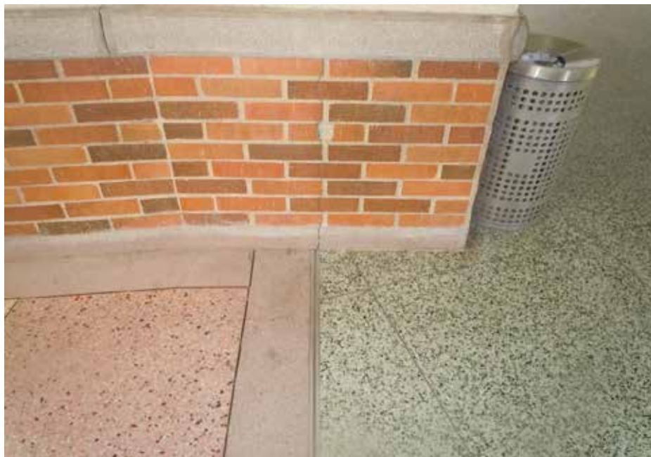
Junta sismica entre modulo 3 y modulo 2.
