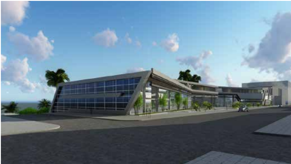
Figura N 35: Acceso Centro de Investigación- Malavé (2017)
