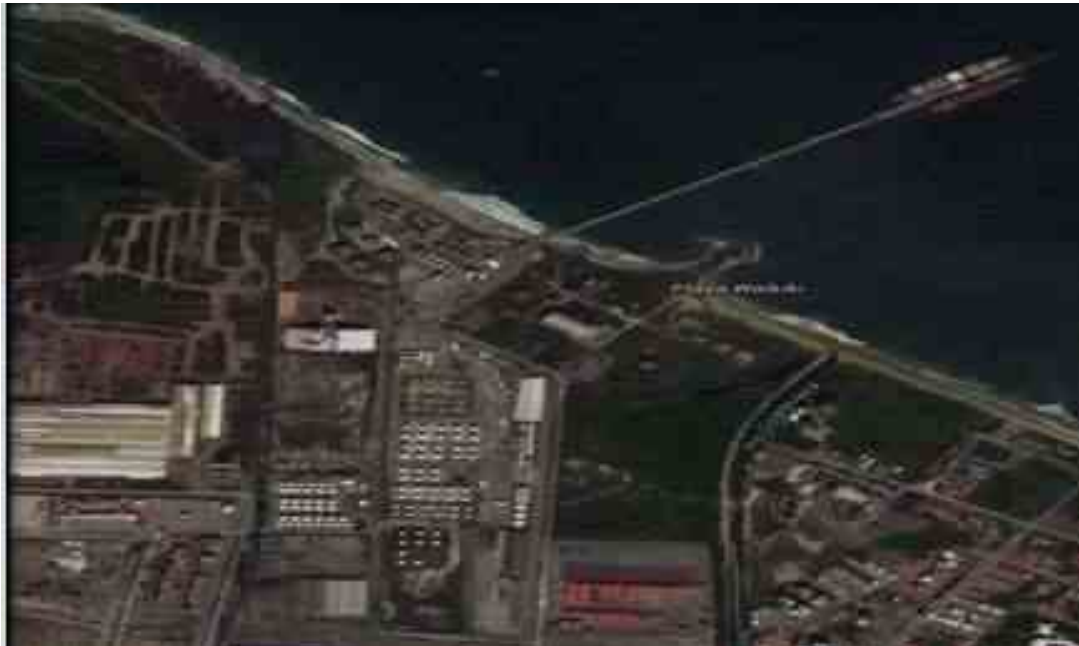
Figura 1 Vista General l Vopak Venezuela, S.A.
