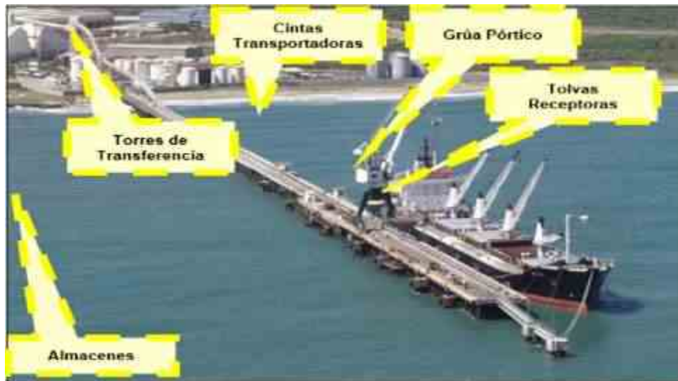
Figura 25: Vista del Sistema de Descarga de Productos Secos. Fuente: Vopak 2020
