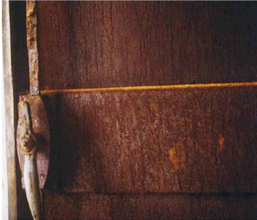
Figura 6: Corrosión Generalizada.
