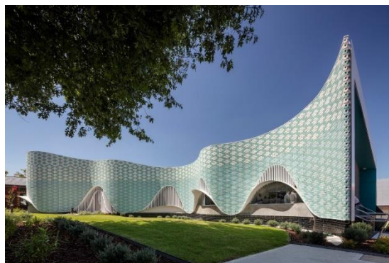
Figura 5: Centro de Música de la Escuela Primaria Penleigh y Essendon
