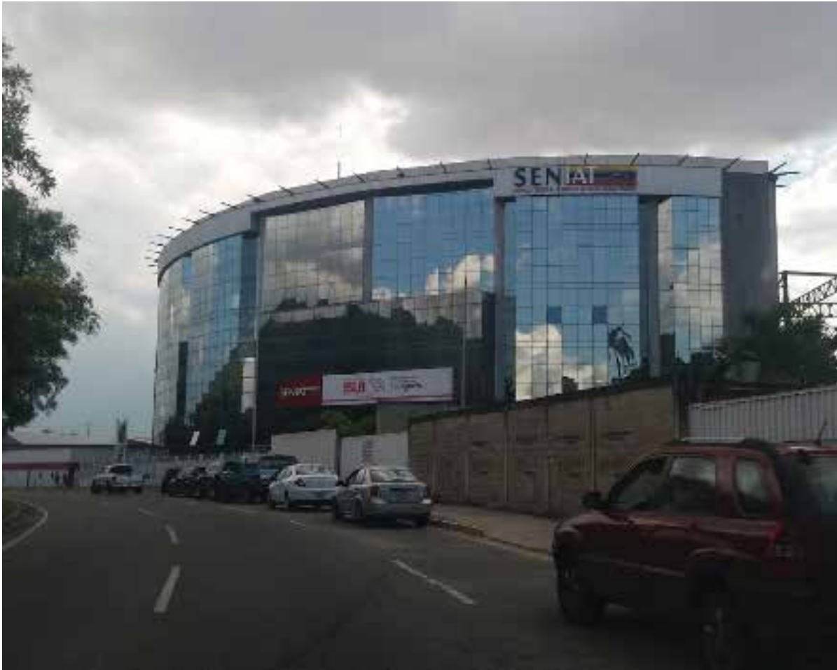
Figura 20. Edificio seniat sector avenida paseo cabriales valencia Carabobo fuente: https://www.google.co.ve/maps/search/seniat/@10.1916779,-68.0021171,18.04z
