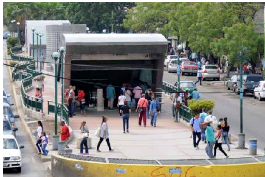
Figura 14. Estación del metro de valencia fuente: https://es.wikipedia.org/wiki/Metro_de_Valencia_(Venezuela)
