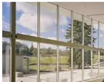
Figura 26. Pared de Vidrio templado translucido.
