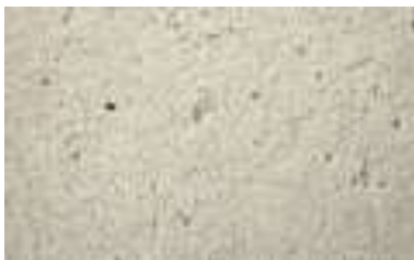
Figura 25. Acabado de fibrocemento sobre pared.
