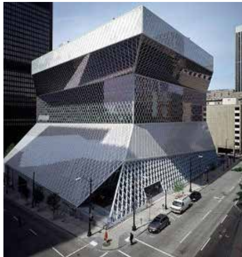
Figura 2. Biblioteca central de Seattle. Fuente: https://www.noticias.arq.com.me.g (2005)
