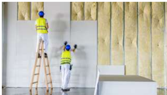
Figura 18. Ejemplo de Drywall. Fuente: https://mavegsa.com/drywall-como-ampliar-o-construir-tu-vivienda-de-manera-economica-y-segura/
