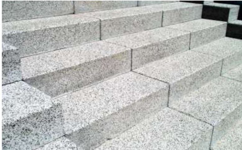
Figura 19. Ejemplo de piso de granito. Fuente:
