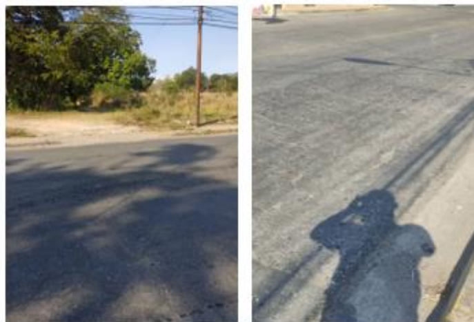
Figura 26 Ahuellamiento.
