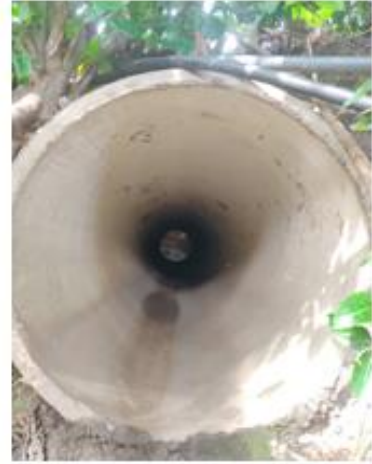
Descarga del sumidero de ventana Hacia la quebrada del rio Autores: González y Torres (2023)
