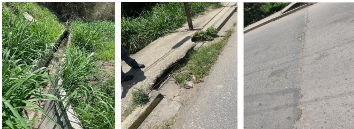
Figura 1: Situación actual de la calle Rondón.
