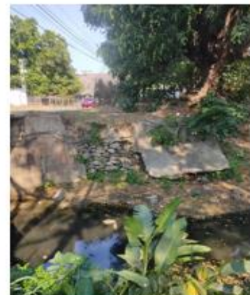
Muro de gaviones existentes Autores: González y Torres (2023)
