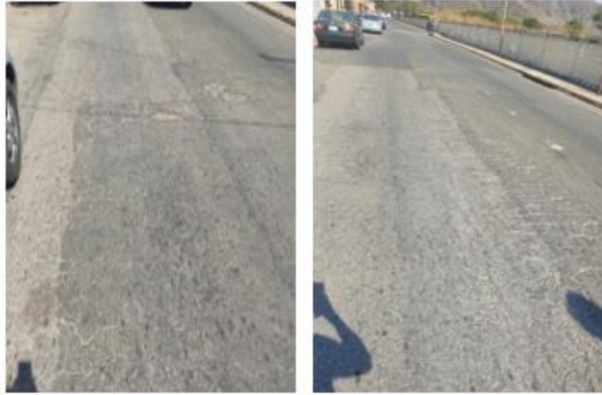
Figura 23 Grieta longitudinal.
