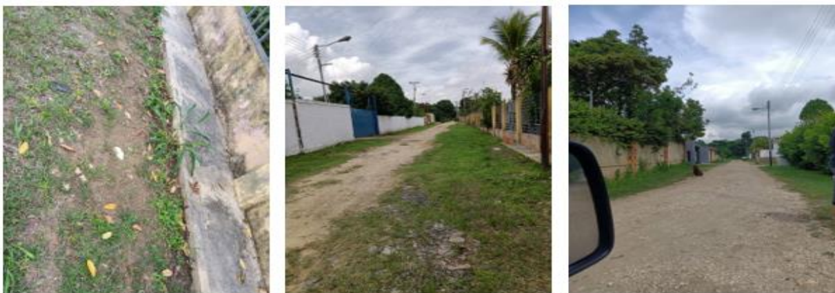
Figura 11 Vía principal del sector los Pavos. Autores: González y Torres (2023)
