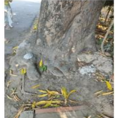
Obstrucción de la caminería Autores: González y Torres (2023)
