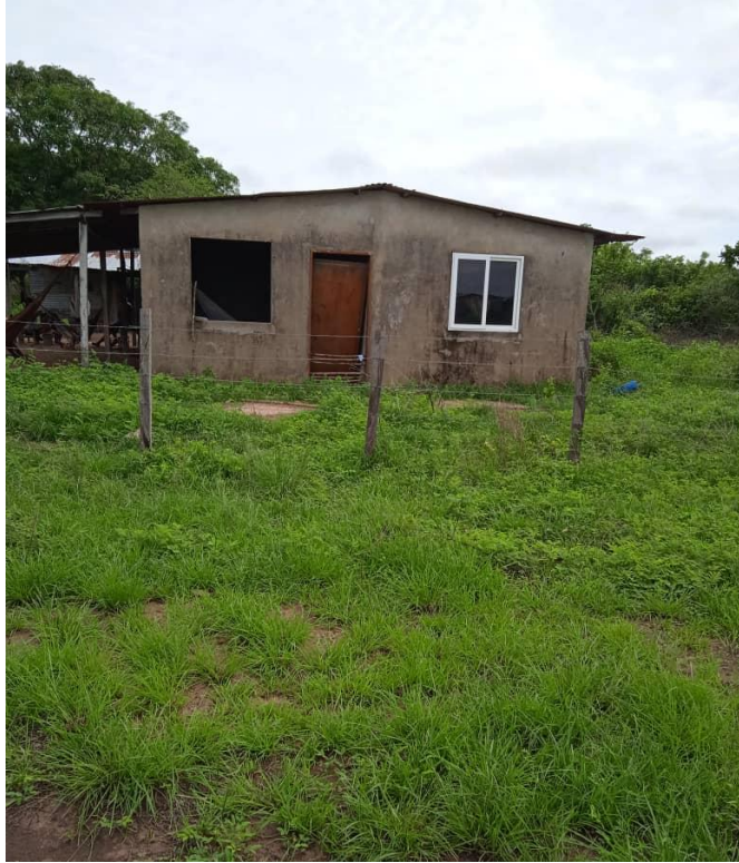
Figura 10: Proyecto de construcción de casas
