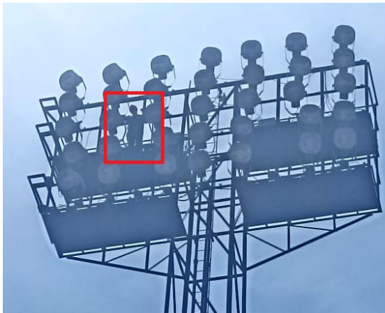
Figura 17. Inspección de las conexiones superiores en la torres
