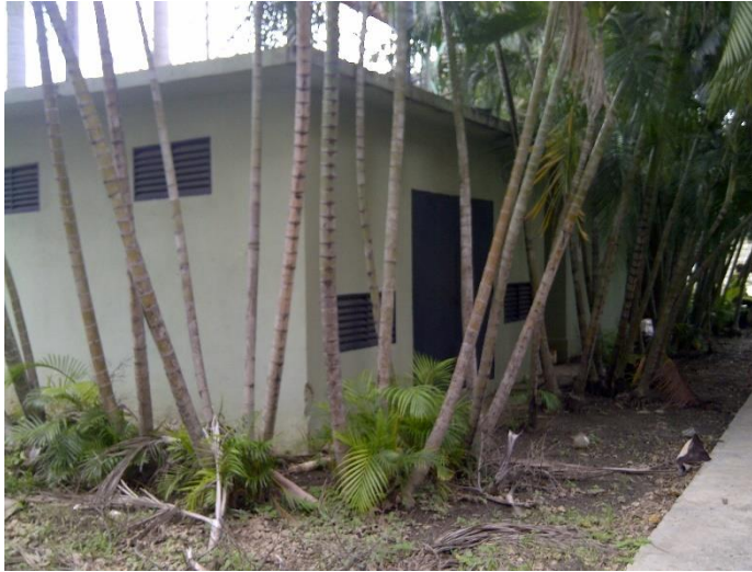
Figura 28. Cuarto de transformación del campo de estudio
