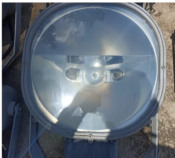
Figura 21. Luminaria desmantelada con lente óptico vidrio protector sucio
