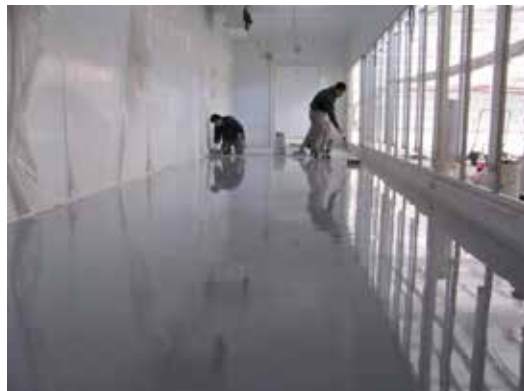
Figura 54: Revestimiento Epoxi en piso (2017)
