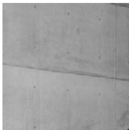
Figura 52: Concreto armado pulido (2017)
