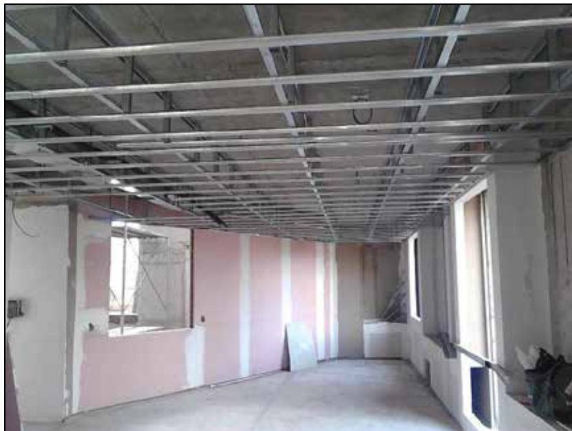
Figura 19: Cielo raso tipo Drywall.
