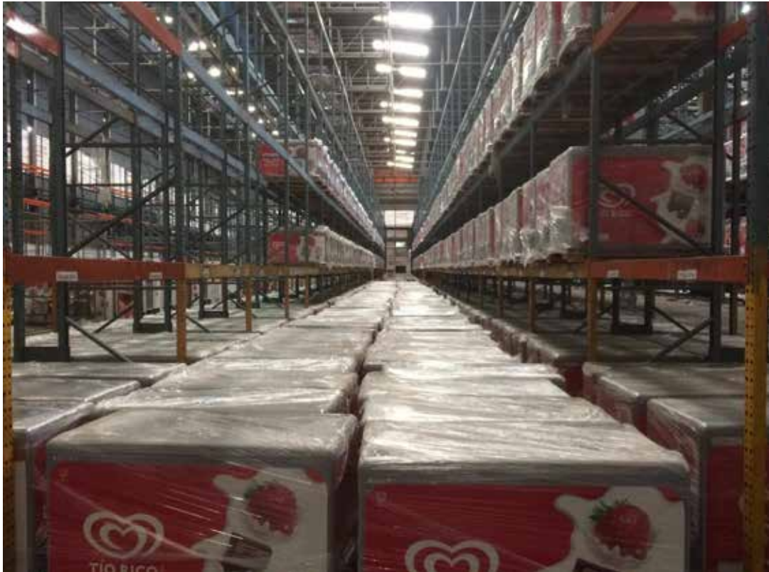
Figura 4. Posición de los racks. Fuente.
