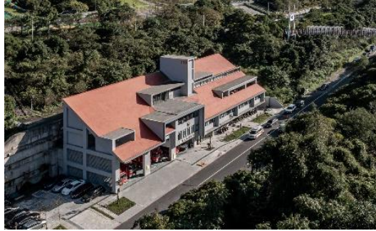
Figura 8: Estación de Bomberos de NuanNuan
