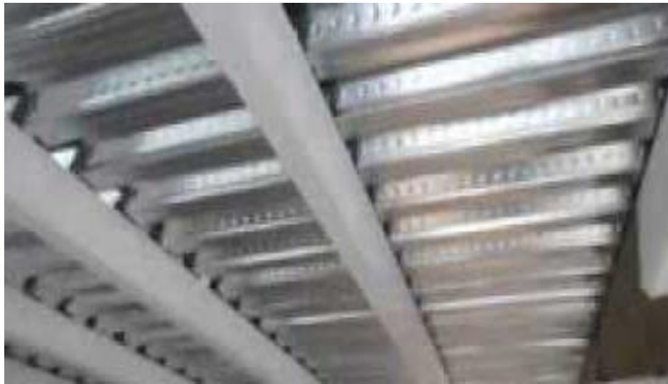
Figura 117. Acabados de la losa acero por el área posterior (2012) fuente: https://i.ytimg.com/vi/c5Pon3amG9k/hqdefault.jpg
