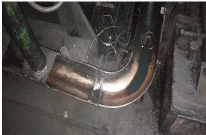
Imagen N°2: Canaletas de recolección de aceites lubricantes en el Banbury 3 Fuente: Deivis Torrealba
