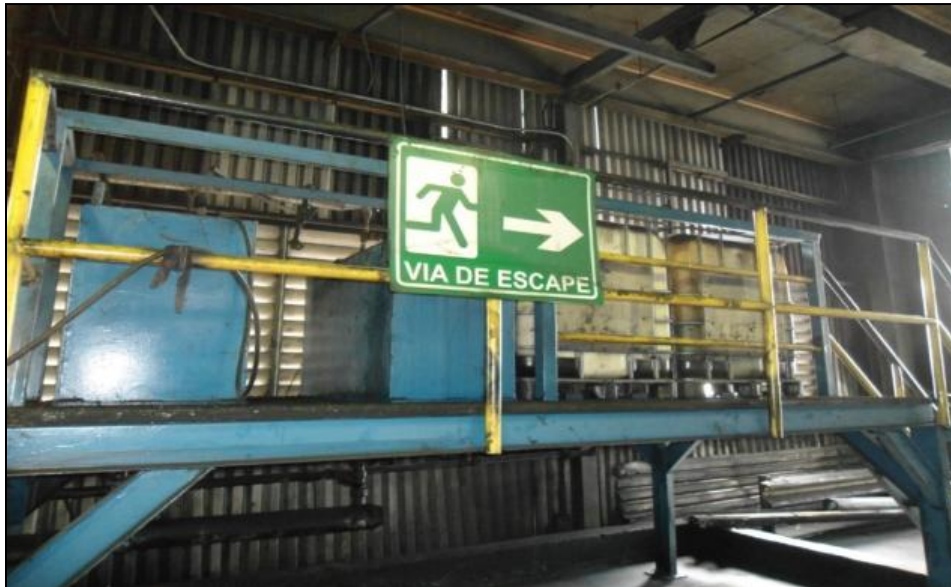
Imagen N°7: Tanques de Almacenamiento y Distribución de Aceite Original Banbury 3
