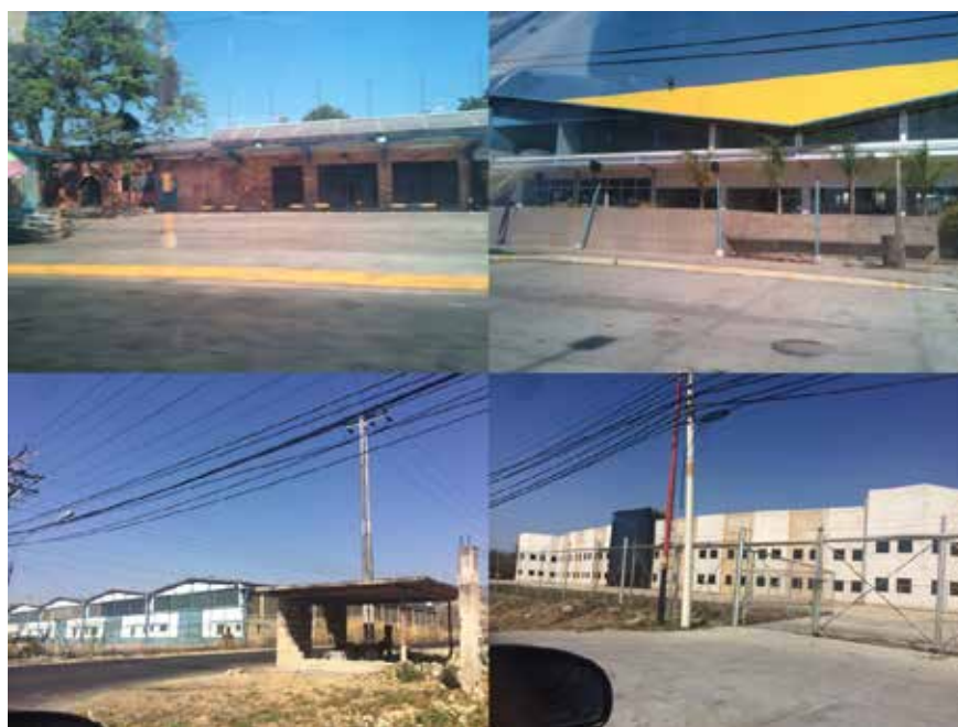
Figura 17: Altura de edificaciones colindantes al sector. (2014)
