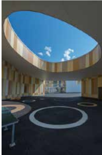
Figura 3. Exteriores del centro comunitario. Fuente: http://www.plataformaarquitectura.cl/cl/784475/centro-comunitario-kastelli-lahdelma-and-mahlamaki . (2014).
