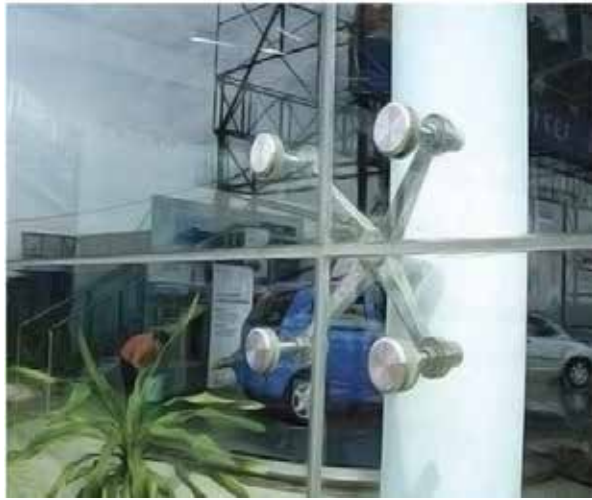
Figura 27. Ejemplo de sistema araña para vidrio templado. (2017)
