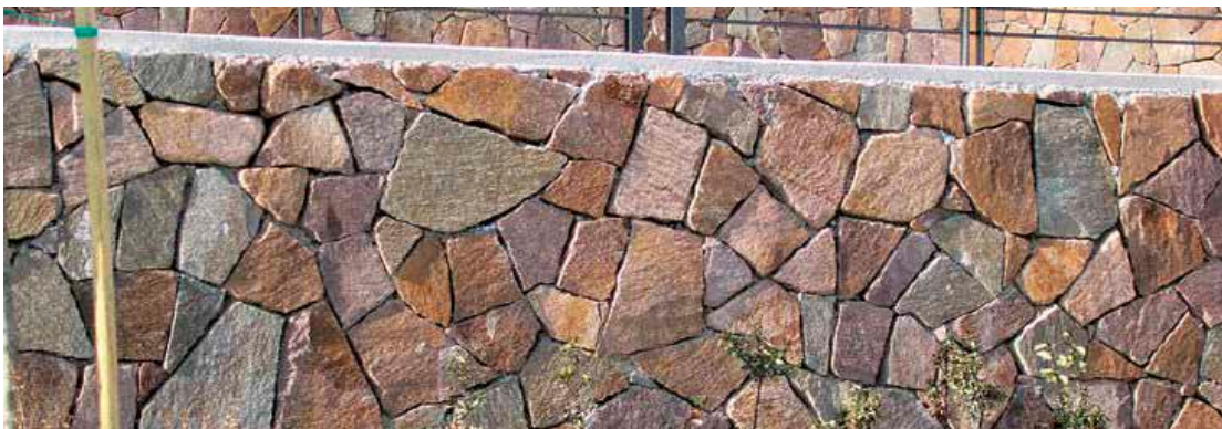
Figura 87: Muro portante de piedra. Fuente: http://www.archiexpo.es/prod/consorzio-cavatori-produttori-porfido-soc-coop/product-55347-311413.html (2016).
