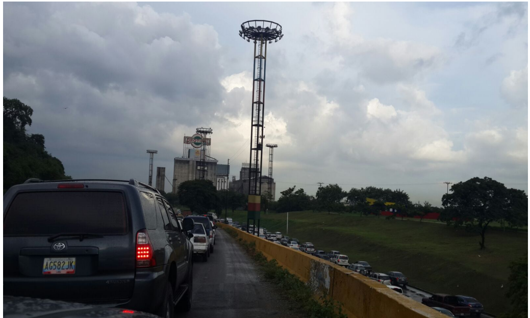
Anexo 2: Distribuidor San blas
