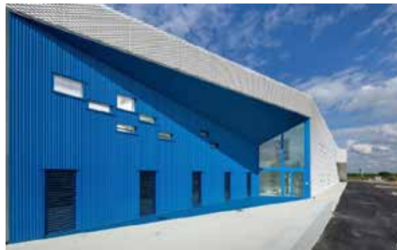
Figura 3. Vista de Fachada. Fuente: https://www.plataformaarquitectura.cl/cl/776675/hde-17-poggi-architecture-plus-more-architecture?ad_medium=gallery (2015)
