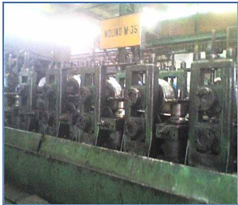
Figura 3 Tren de formación de tubos. Fuente: Propia (2019)
