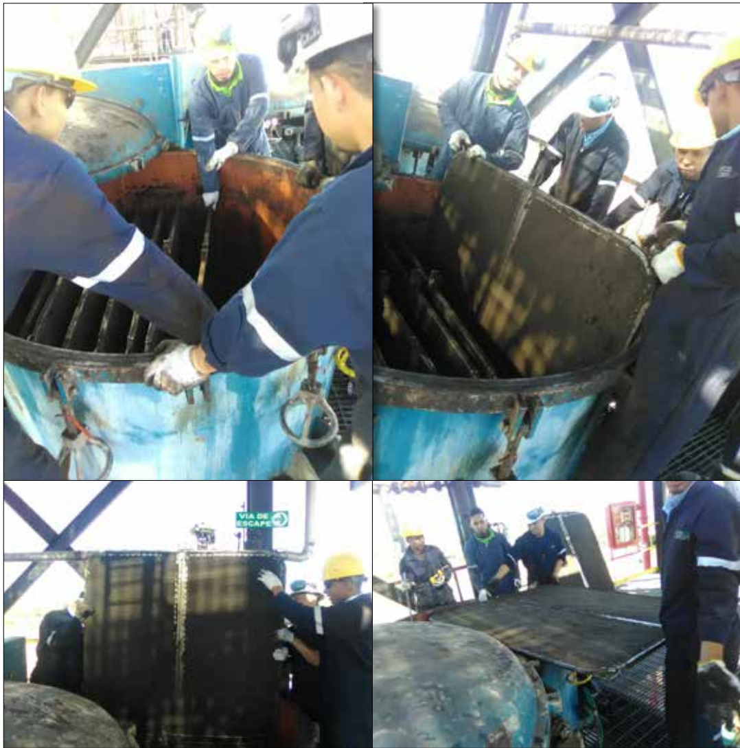
Figura 28. Extracción de las placas.
