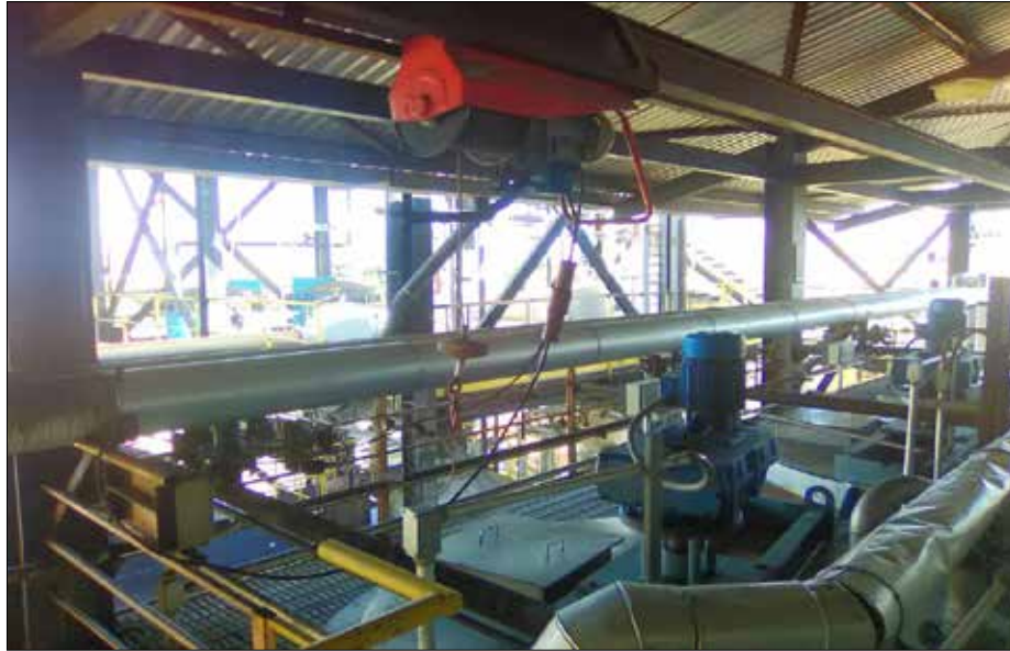
Figura 37. Ubicación del polipasto eléctrico propuesto. Fuente: Ruiz, J. (2020).
