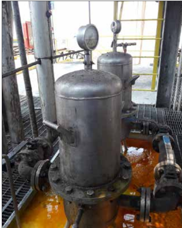
Figura 21. Micro filtros de Seguridad (MF-501/502).
