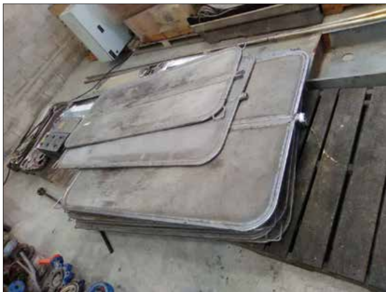
Figura 12. Placas fracturadas en el almacén Fuente: Ruiz, J. (2020).
