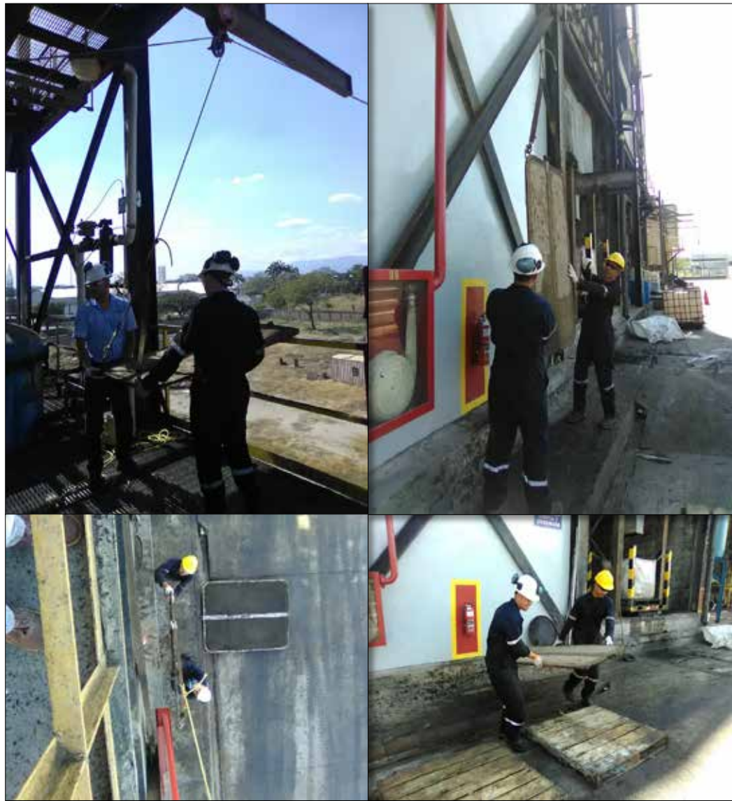
Figura 29. Descenso de las placas de los filtros verticales (PLF-501/502).
