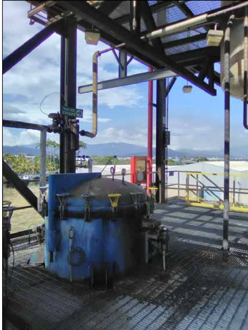
Figura 36. Vigas doble T en la parte superior de los filtros.
