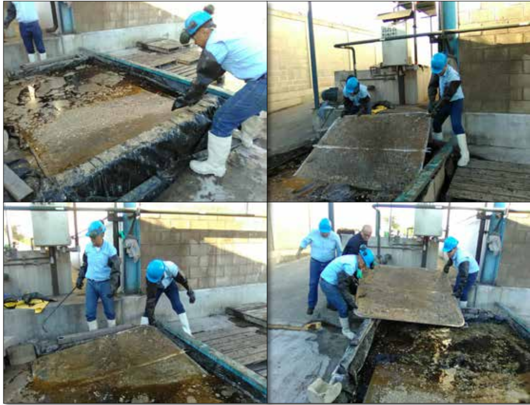
Figura 31. Trabajadores realizando el tratamiento químico de las placas.
