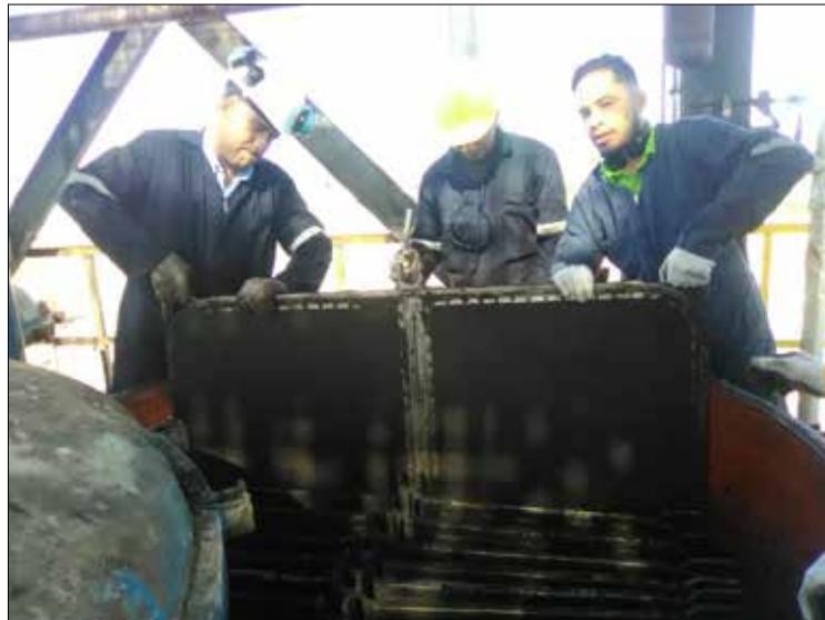
Figura 9. Retiro de las placas del filtro Fuente: Ruiz, J. (2020).
