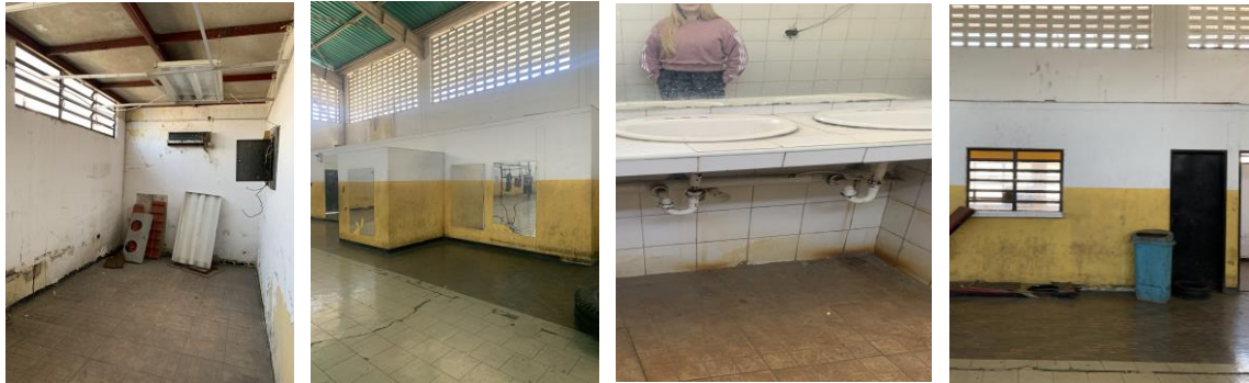
Imagen 03. Gimnasio de Boxeo Jorge Romero Celis “El Puño”, ubicado en La Isabelica, estado Carabobo. Instalaciones de servicio. Imágenes tomadas por la autora (2023).
