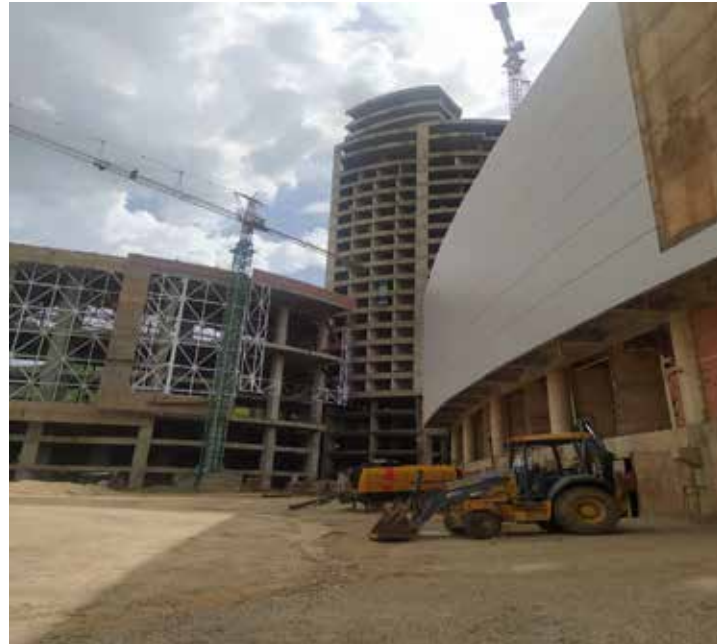
Fuente 3: Equipos y maquinarias.
