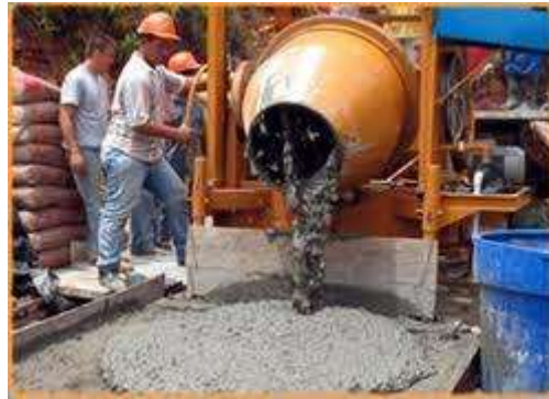
Figura 2. Preparación mezcla de concreto mediante tambor rotatorio.
