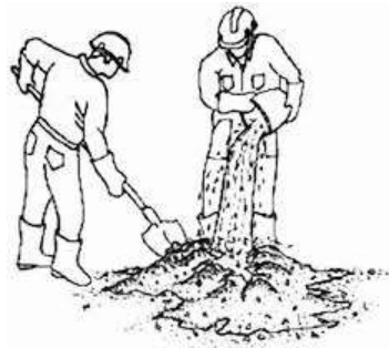
Figura 1. Preparación mezcla de concreto de forma convencional.
