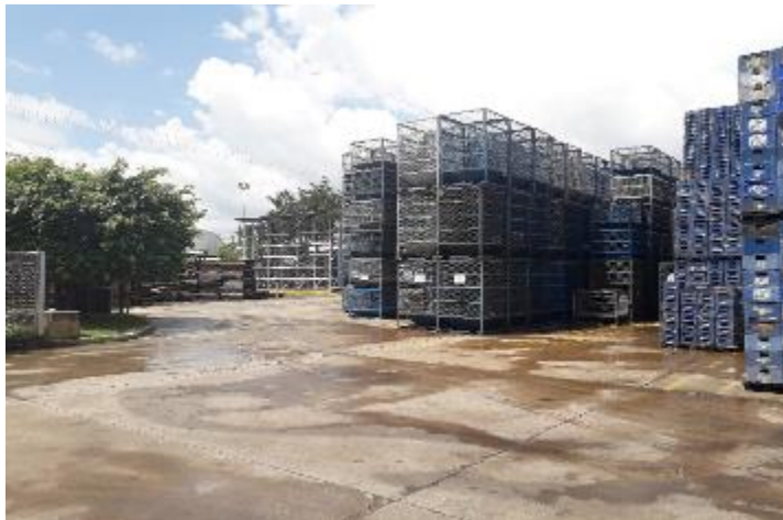
Figura 31: Patio de Gaveras, Contenedores no aptos.
