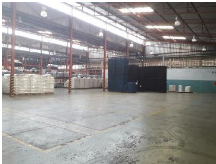
Figura 26: Almacén de Producto Terminado de Plástico.
