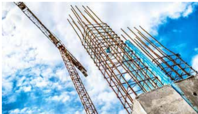
Imagen 34. Columnas. Fuente: www.Google.com.ve
