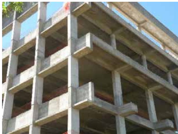
Imagen 30. Estructura. Fuente: www.Google.com.ve
