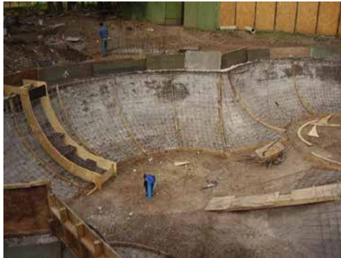
Imagen 6. Instalación de moldaje superior para rebalse de shocrete. Fuente: http://repositorio.unab.cl/xmlui/bitstream/handle/ria/1711/Romero_D_Skate%20Park%20parque%20Ohiggins_2012.pdf?sequence=1&isAllowed=y (2012).
