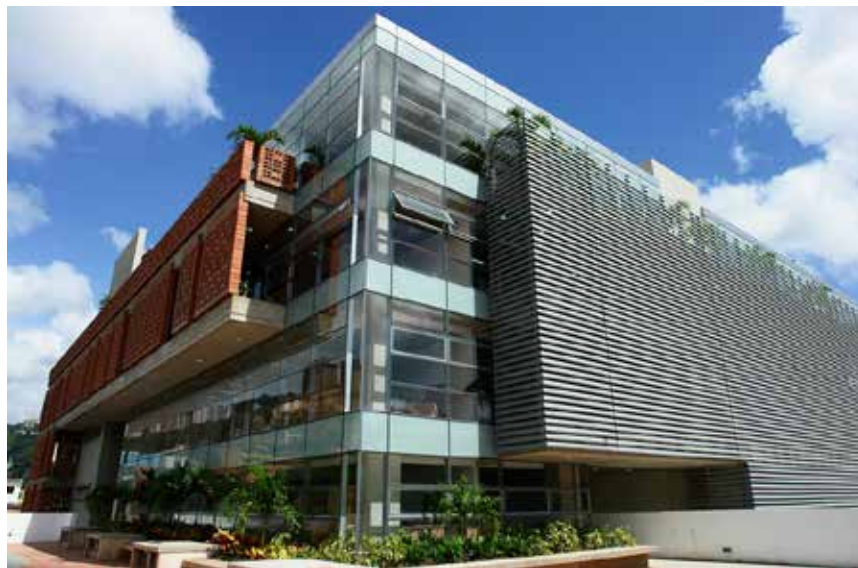
Figura 2: Edificio de Alcaldía de Baruta. Fuente: http://www.plataformaarquitectura.cl/cl/609603/nueve-sede-de-alcaldia-de-baruta-franco-micucci-dalessandri (2014).
