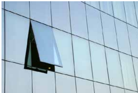
Figura 21: Curtain Wall de fachadas del edificio. (2015).
