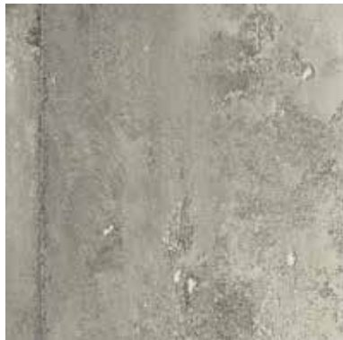
Figura 47: Acabados en cemento rústico. (2020)
