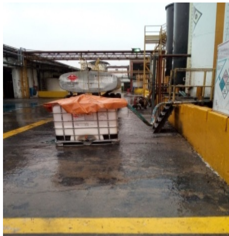
Foto N°5: Descarga tanto de cisterna como tambor o maxi cubo.
