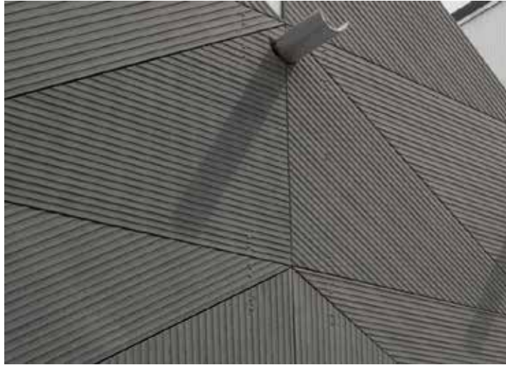
Figura 23. Acabado de Paneles de Fibrocemento Texturizado Fuente https://bit.ly/34OSJsT Revestimiento en Paredes internas y externas de Áreas principales
