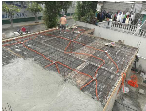
Gráfico 48: proceso constructivo de losa maciza. Fuente:
