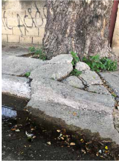
Figura 7: Levantamiento de brocal en el tramo C-D
