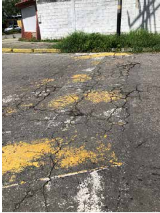
Figura 17: Piel de cocodrilo en el reductor de velocidad H-I
