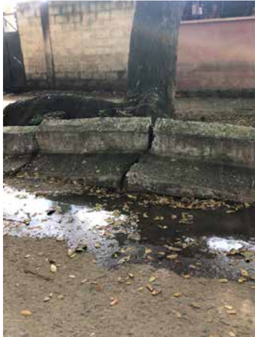
Figura 9: Levantamiento de brocal en el tramo E-F
