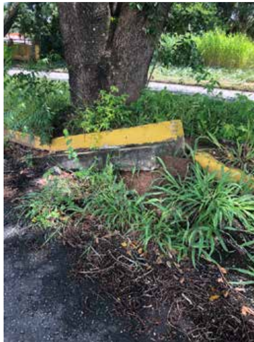
Figura 14: Levantamiento de brocal en el tramo G-H
