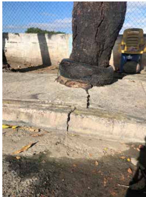
Figura 2: Levantamiento de brocal en el tramo A-B
