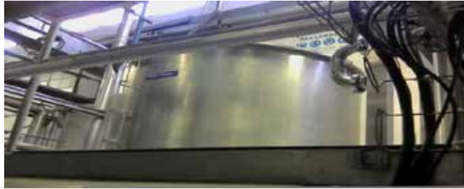
Figura 13 Run Tank o tanque de almacenamiento Autor: Ocanto A. (2017)
