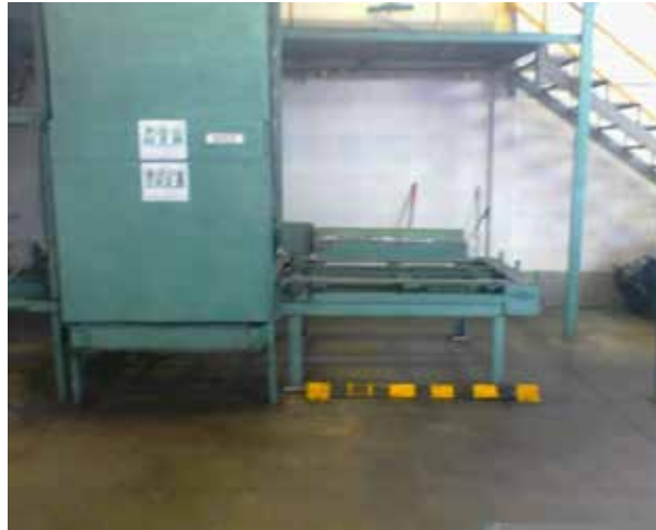
Figura 15 Zona de carga del Despaletizador Autor: Ocanto A. (2017)
