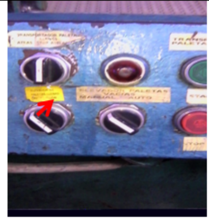
Imagen #14 Selector bomba elevador en "ON"
