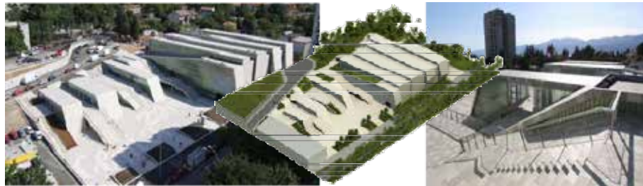
Figura 2: Centro Zamet. Fuente: www.google.co.ve (2009)
