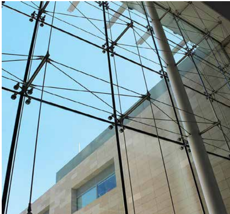
Figura 27: Vista de sistema Curtain Wall Fuente: https://static1.glasscon.com (2020)
