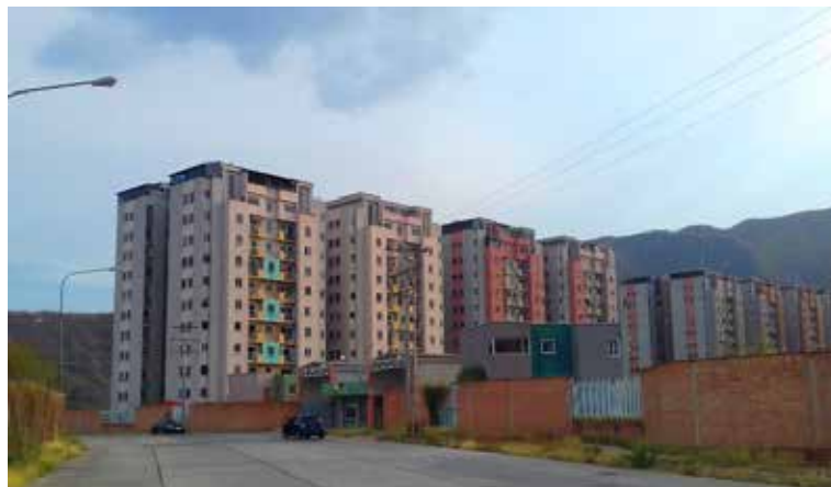
Figura 18: Residencias Montemayor (12 Niveles) Fuente: Camera: Luis Chaviel. (2020)
