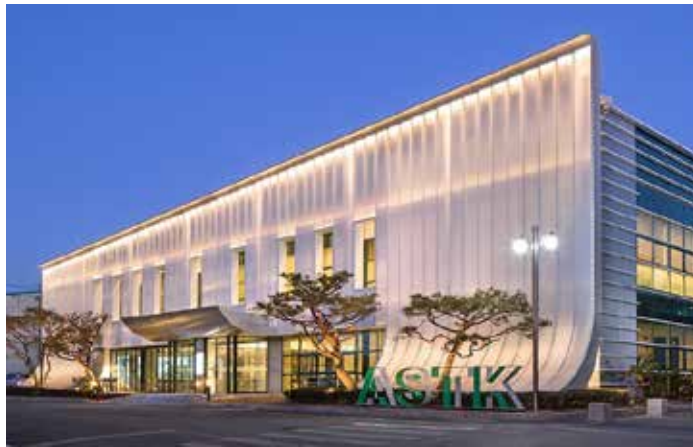
Figura 36. Sistema Modular de Policarbonato Danpalon. Fuente: http://www.plataformaarquitectura.cl/catalog/cl/products/9881/sistema-modular-de-policarbonato-danpalon (2020)
