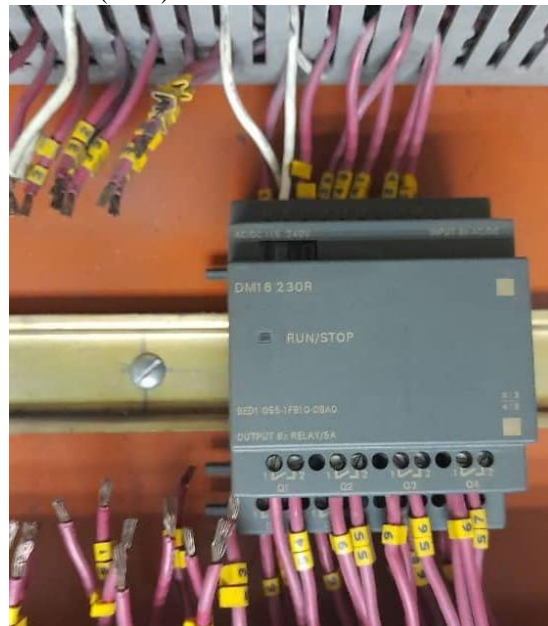
Figura 20. Modulo de expansión DM16 Fuente: Bortot, S. (2022).
