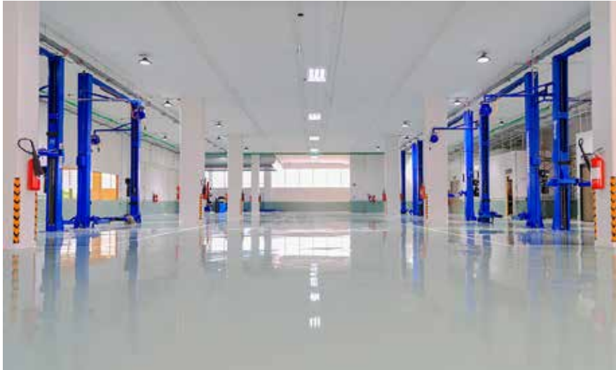
Figura 33: Piso epóxico. Fuente: https://psiconcreto.com/pisos-epoxicos-todo-lo-que-debes-saber/ (2020)
