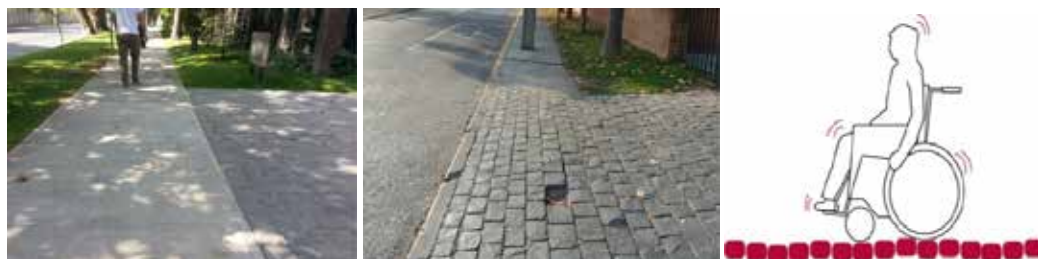
Figura 14: Presencia de desnivel e irregularidad
