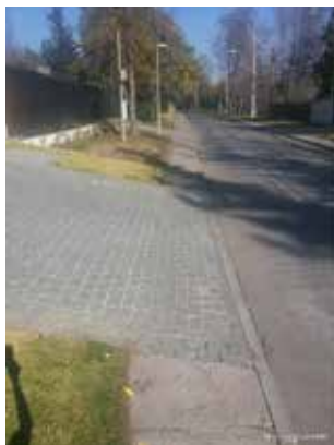
Figura 11: Pendiente de acceso mayor al 2%
