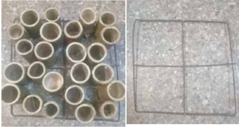
Figura: Molde perimetral en cabilla tripa de pollo.
