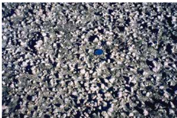
Figura 14. Disgregación.
