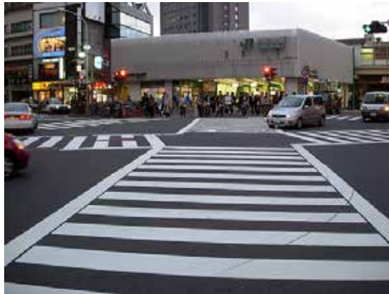
Figura 54. Demarcación “RAYAS PARA CRUCE DE PEATONES”.
