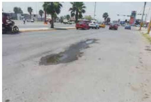
Figura 16. Hundimiento.
