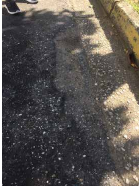
Figura 100. Disgregación.
