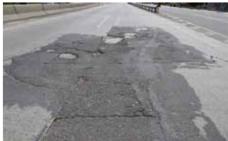
Figura 10. Parches deteriorados.
