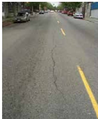
Figura 8. Grieta longitudinal.
