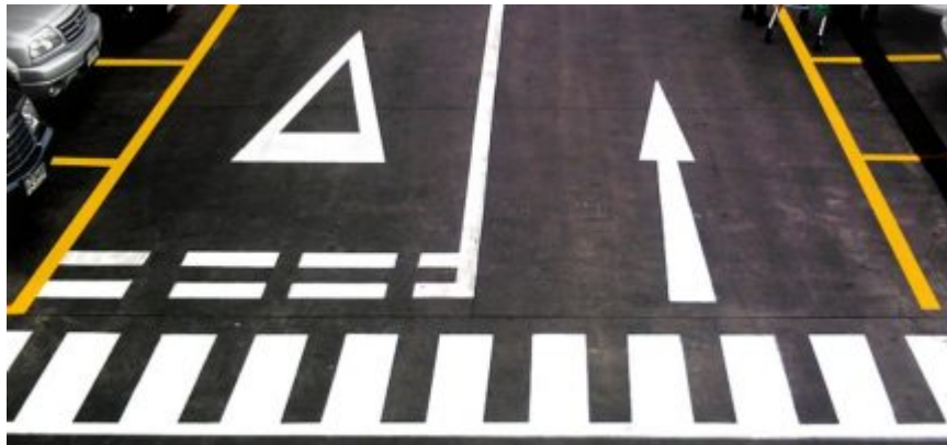
Figura 53. Demarcación “RAYAS DE PARADA”.
