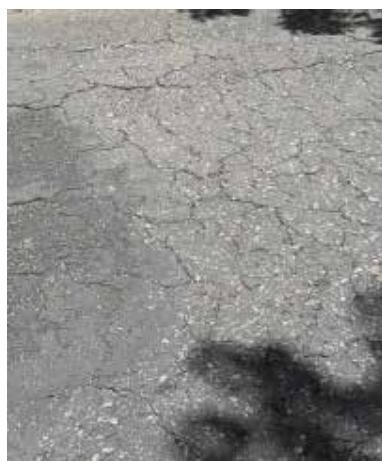
Figura 84. Falla por bloque en el tramo estudiado.
