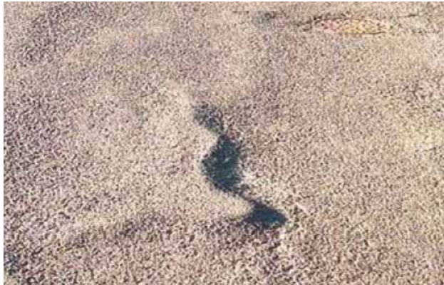
Figura 18. Deformación por empuje.
